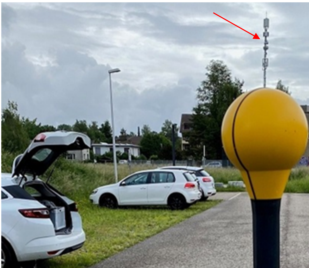
Photo 5: Basisstation (roter Pfeil) und Messantenne
